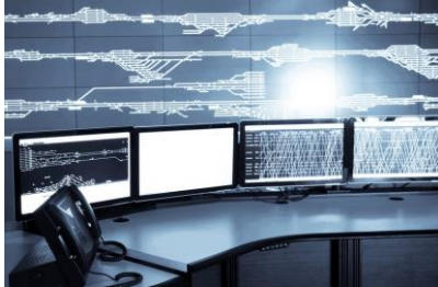
Sentral styring og overvåkning
