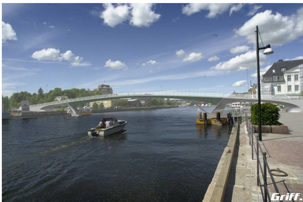
Figur 3.13. 60 m gangbro over Glomma i Fredrikstad. Broen er en mekanisk klaffebro og de to heveklaffene, hver på 30 m, er laget i kompositt- og sandwichmaterialer.
