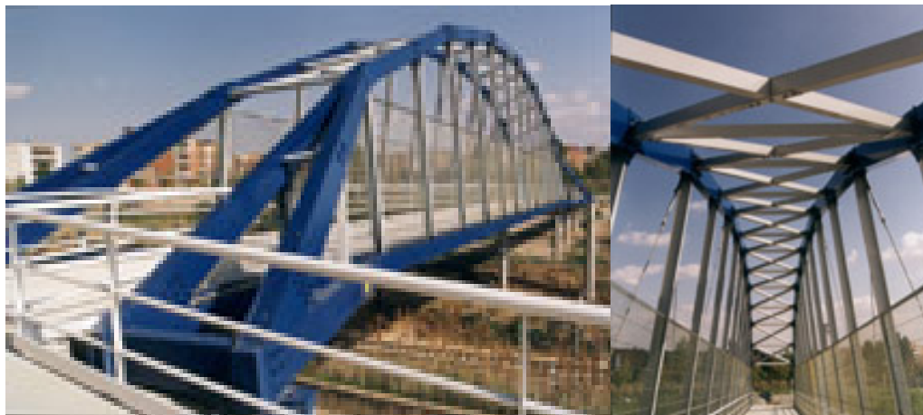
Figur 3.14: Gangbro i kompositt på 38 m i Spania. Broen er bygd opp av rette pultruderte profilelementer som er satt sammen ved hjelp av fittings i syrefast, rustfritt stål.
