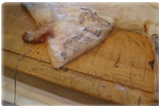
Bilde 4-6 a) Fjerning med fryseelement – før frysing og fjerning
