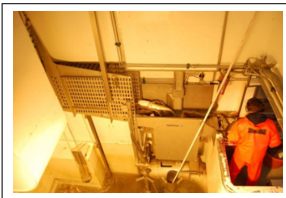
Bilde 18 Bløggestasjon ved dragerbrønn
