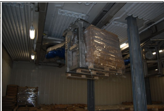
Bilde 27 Kraning til plass i lasterom
