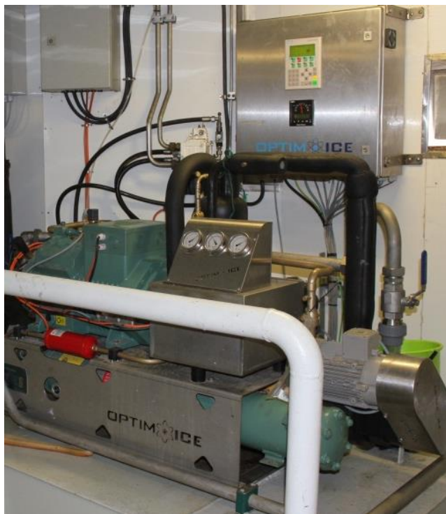
Figur 2.3 Isslurry-anlegget om bord i M/S Loran.
