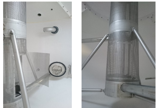
Bilder av en tank innvendig.
