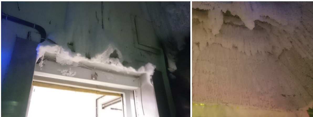
Figur 19 Isdannelse innenfor port til fryselager
