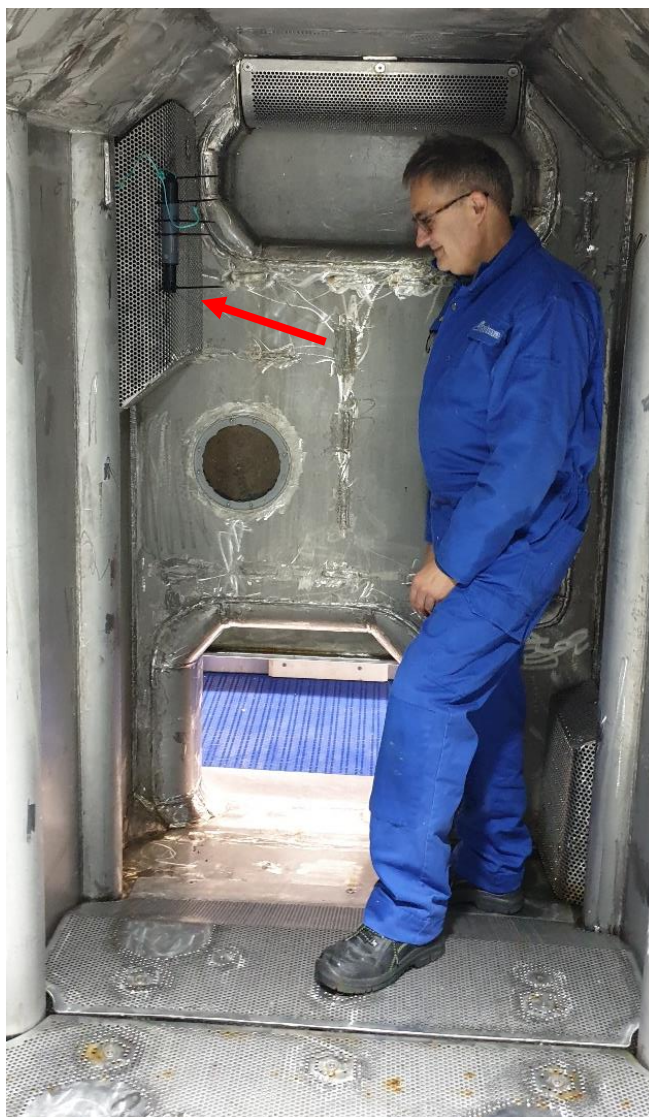
Bilde 1 Montering av oksygenlogger i mottakstank nr. 3. (flat bunn) av Gustav Martinsen
