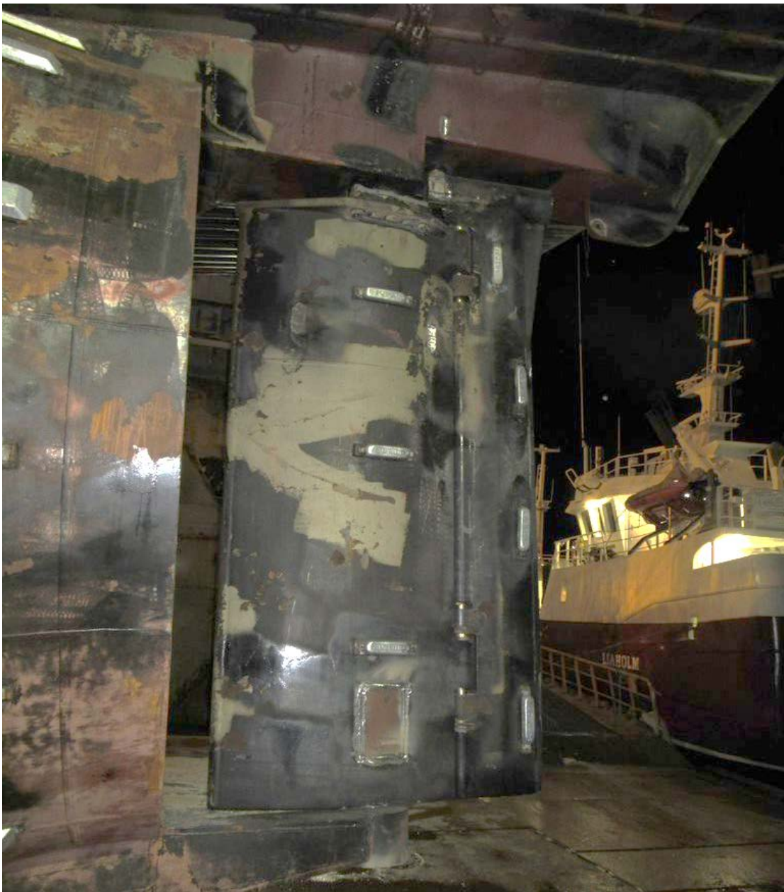
Figur 4-31 Oversiktsbildet av reparert rør med anoder
