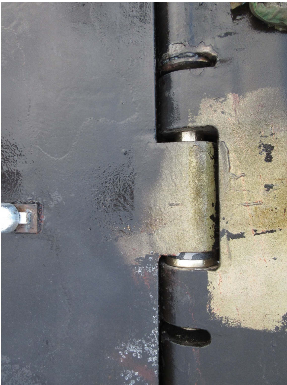
Figur 4-32 Gjennomføring av karbonstålaksling på flap-mekanisme
