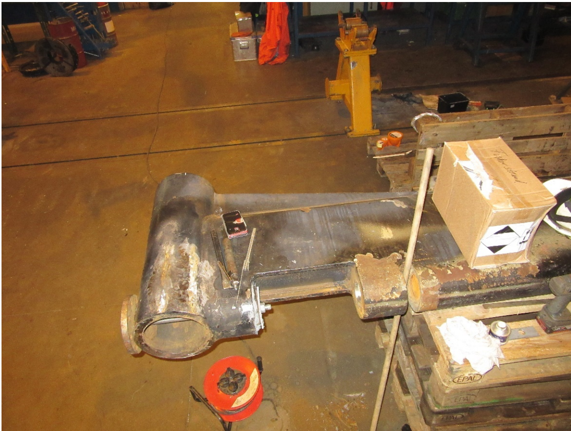
Figur 4-34 Oversiktsbilde av rorflaps og flapmekanisme under reparasjon
