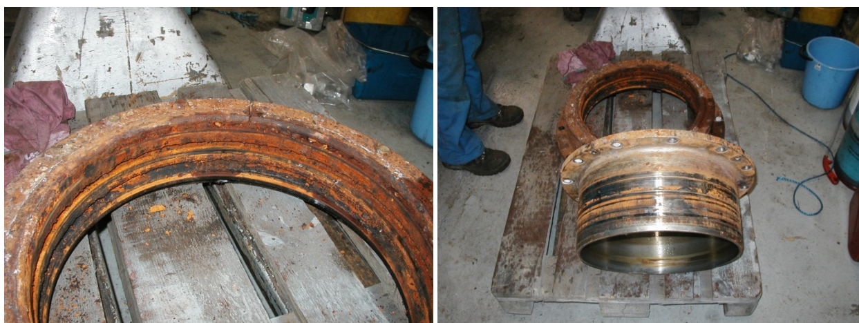
Figur 21. Korrosjon på hylsetetning i støpejern med liner i modifisert karbonstål
