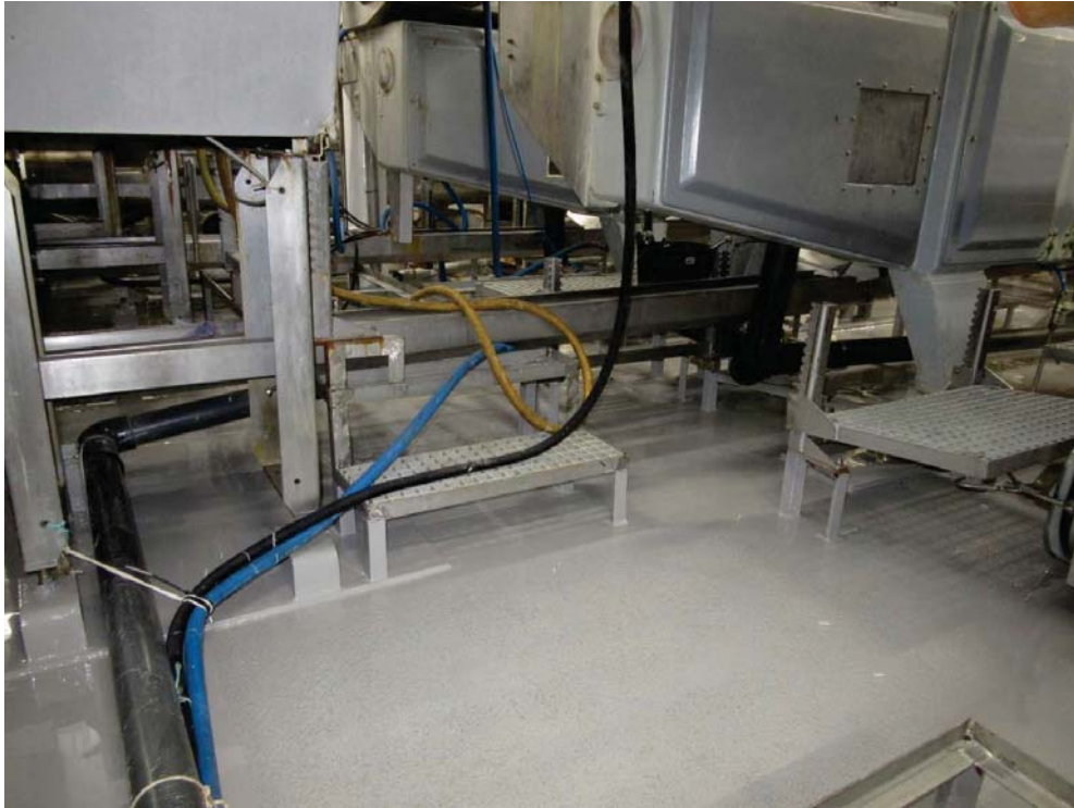
Figur 27. Nymalt fabrikkdekk i karbonstål med malte rustfrie bein og festeplater
