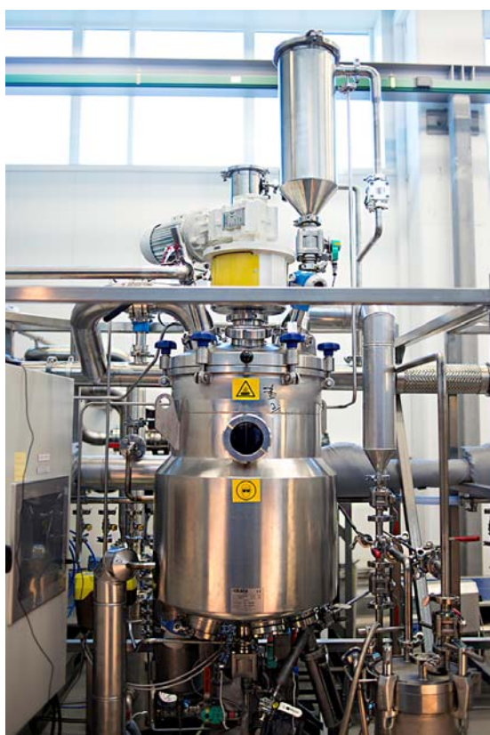
Foto: SINTEFs raffineringsanlegg for marine oljer
