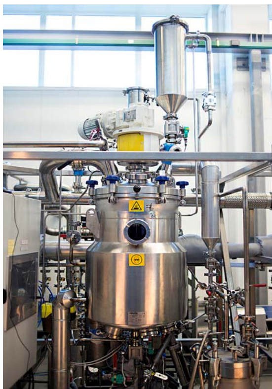
Foto: SINTEFs raffineringsanlegg for marine oljer
